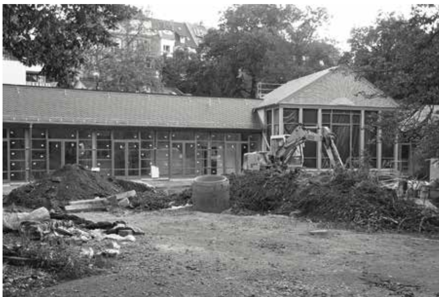
Baustelle Kindergarten | Foto:Born
